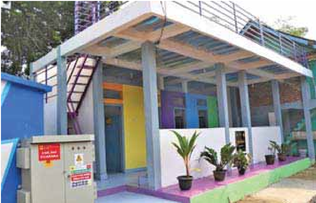
Foto Sanitren yang telah selesai dibangun 5
